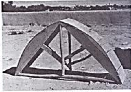
ساخت قالب دبه چوبی برای اجرای تاق زنی ایلامی
