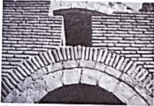
اجرای همزمان سه شیوهی اجرایی در ایوان خسرو - تخت سلیمان در این تصویر به ترتیب از پایین به بالا: اجرایی شری، چپله و روسی اجرا شده است
