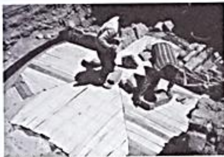
ساخت قالب دبه چوبی برای اجرای تاق چهاربخش به روش ایلامی
