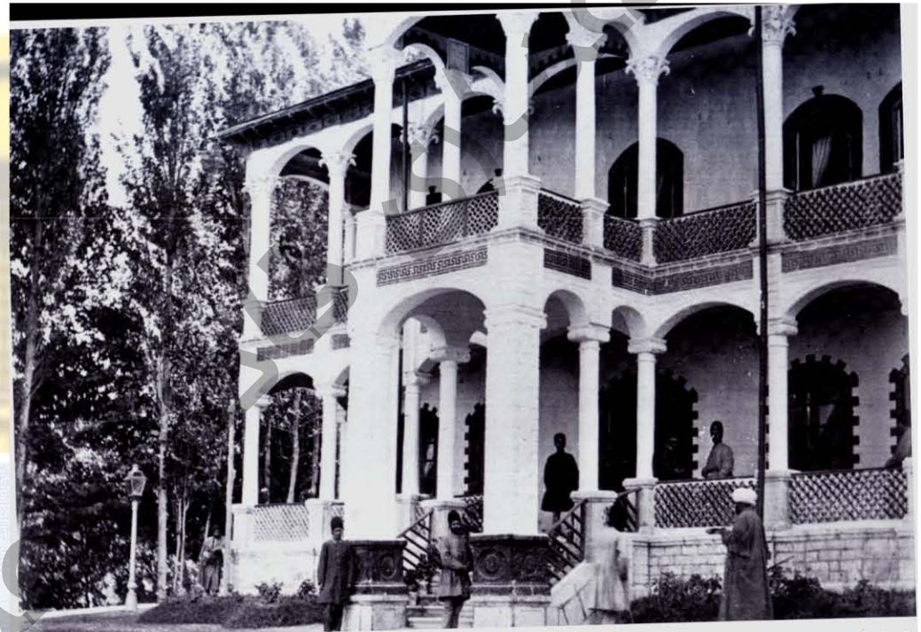
نماهای بارز در نمای اصلی قصر یاقوت شامل راه پله در محور، بالکن در بالای ورودی، قوس‌های گمانی، ستون‌های آیونیک و کورینتین و سنگ تاج است. این نمادها در شیوه اسفهبانی سابقه ندارند.
