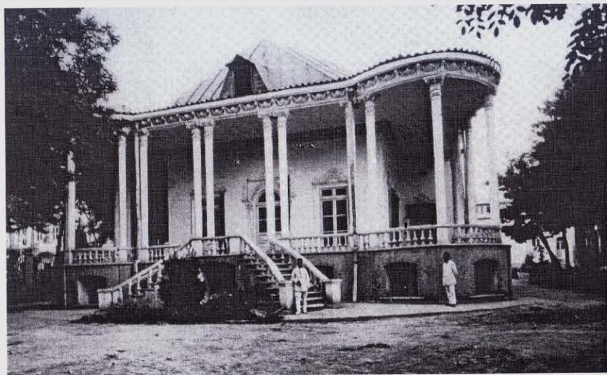
در جنوب نمای اولیه کاخ ملیجک، بام شیب‌دار با پوشش شیروانی، ستون‌های کامپوزیت، نرده به شکل صراحی، پله در محور ورودی، تزئینات نئوکلاسیک و تقارن ملاحظه می‌شود.
